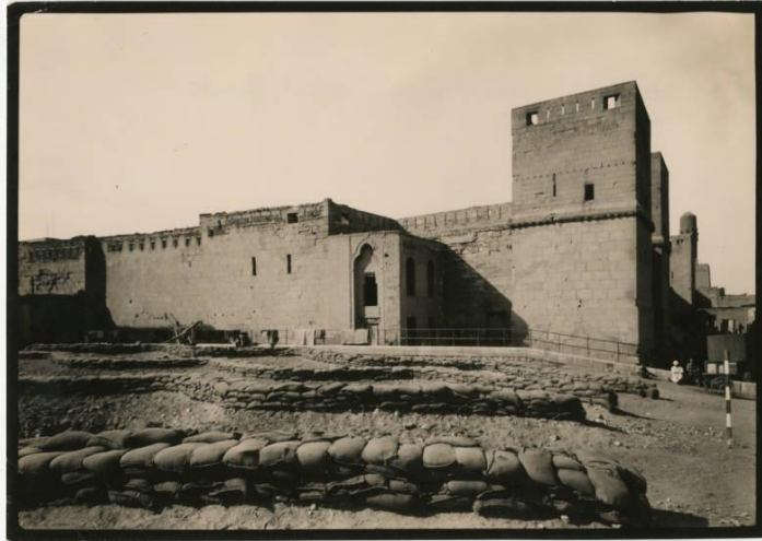
لوحة رقم (١٥) صورة فوتوغرافية لكريزول (١٨٧٩-١٩٧٤) (٤٩) . ويظهر فيها واجهة أحد المنشآت الملاصقة وهي واجهة صماء أقصى اليمين يفتح بها المدخل الرئيسي مكون من حجر غائر متوج بعقد مدانتي بسيط، تبدأ من أسفل بفتحة مستطيلة يغلق عليها مصراعان من الخشب يعلوه عتب مستطيل من صنجات يعلوه فتحة نافذة مستطيلة.
